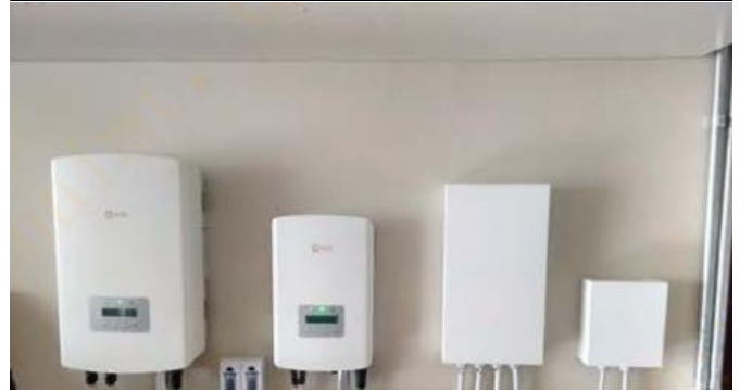
图表 10. 组串式逆变器示意图
