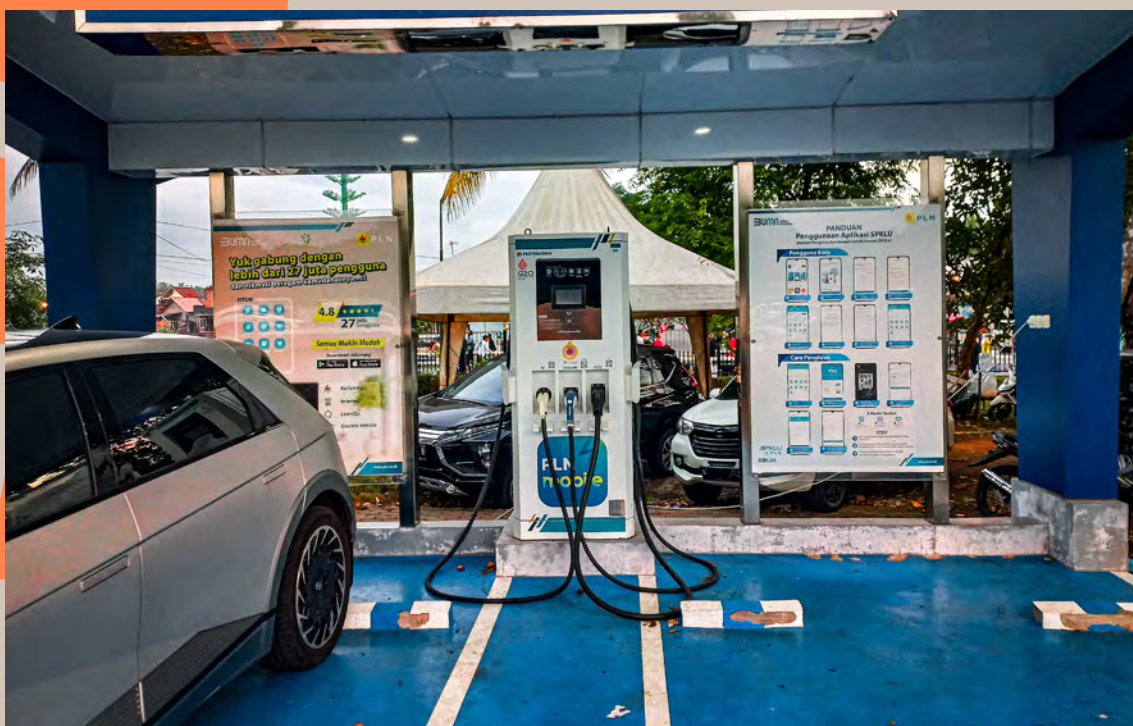
印尼中爪哇的电动汽车充电站。
