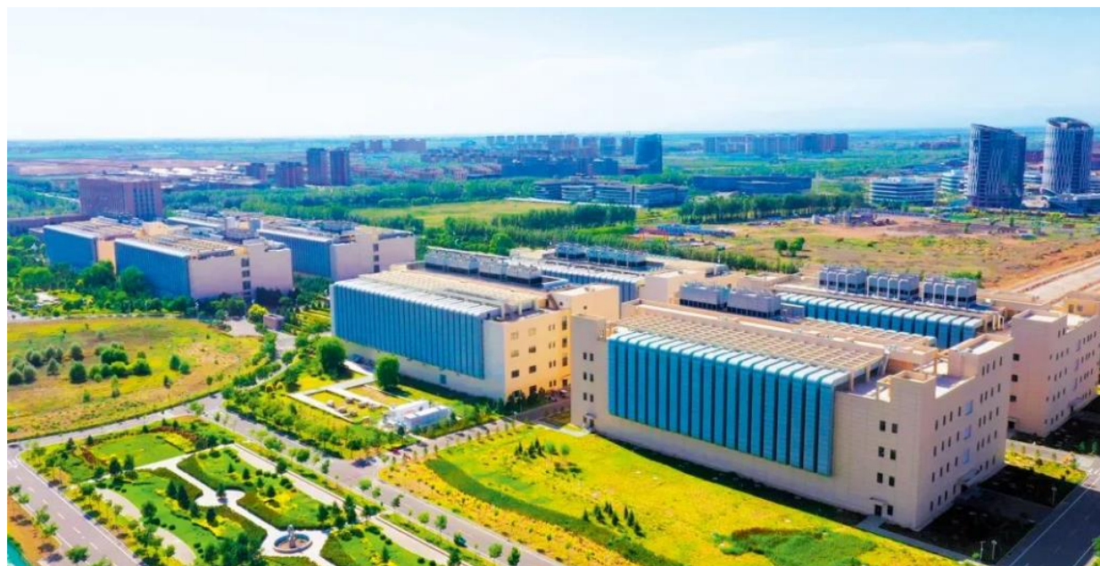
图 9：林格尔数据中心集群
